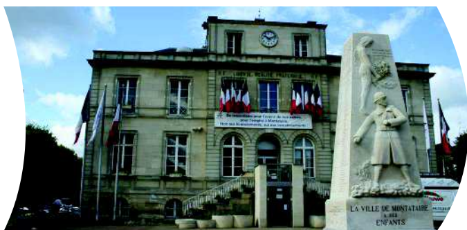
Mairie de Montataire © Agglomération Creil Sud Oise
